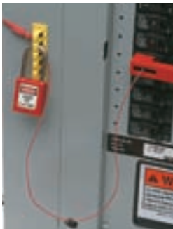
将塑料钥匙穿过锁具阻杆定位孔然后使用挂锁，防止钥匙沿着线缆滑落并打开锁具。
