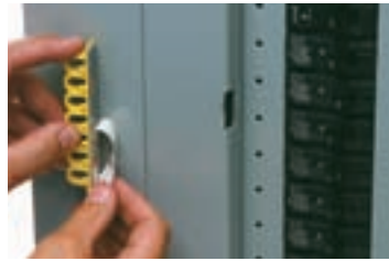
撕去锁具阻杆底部的衬垫，露出高粘性层。可永久粘贴在面板上的任何位置。不需钻孔！
