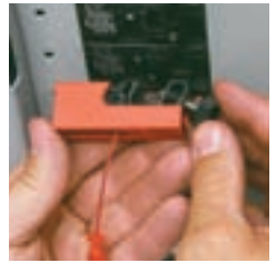
将锁具固定到断路器并推入锁紧位置。
